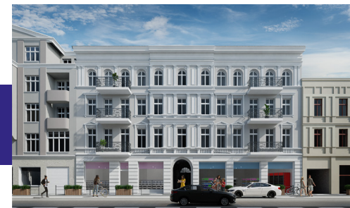
Widok budynku od strony ulicy
